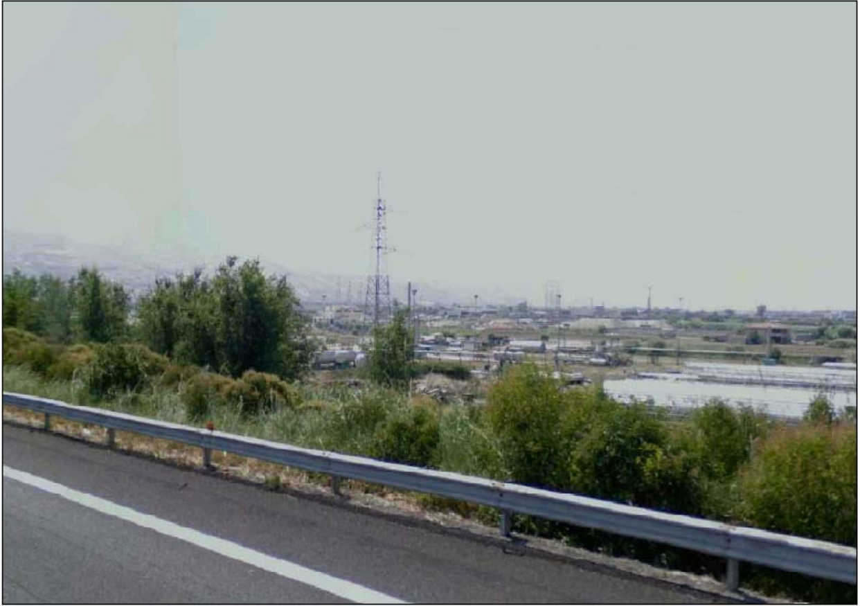
Figura 2: Vista attuale della Centrale gas S. Benedetto dall'A14
