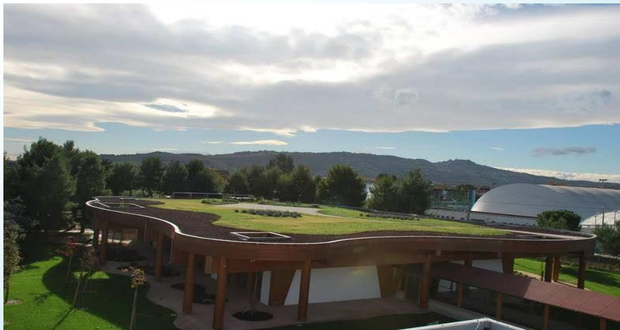
Ampliamento scuola esistente, edificio ad alta efficienza energetica con struttura e finiture in legno, tetto – giardino e impianti fotovoltaico, solare – termico e geotermico.
