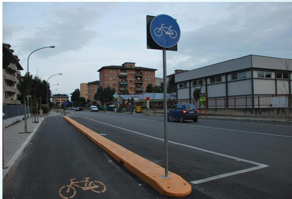
Abbattimento delle barriere architettoniche, adeguamento dei marciapiedi delle vie Mattei e Rubicone, nuovo percorso ciclabile dalla rotonda di via Mattei alla pista ciclabile già esistente che corre parallela al rilevato ferroviario, marciapiede in via Foglia.
