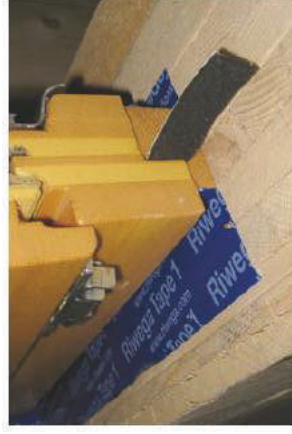
GAE UNIVERSAL tra serramento e falsotelaio
