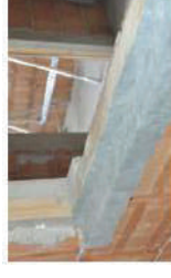
Tre diverse tipologie di applicazione per sigillatura ed impermeabilizzazione del lato inferiore del falso telaio
