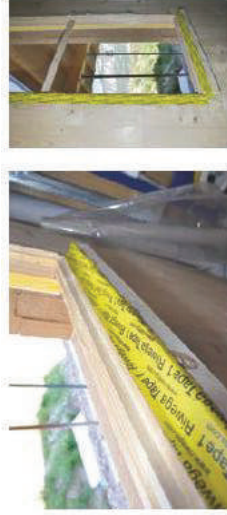
USB Tape 1 PAP X3 a sigillatura tra falsotelaio e parete in legno
