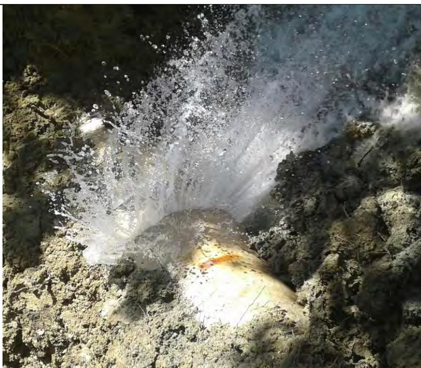
Sisma 2016: Rottura condotta Acquedotto Pescara
