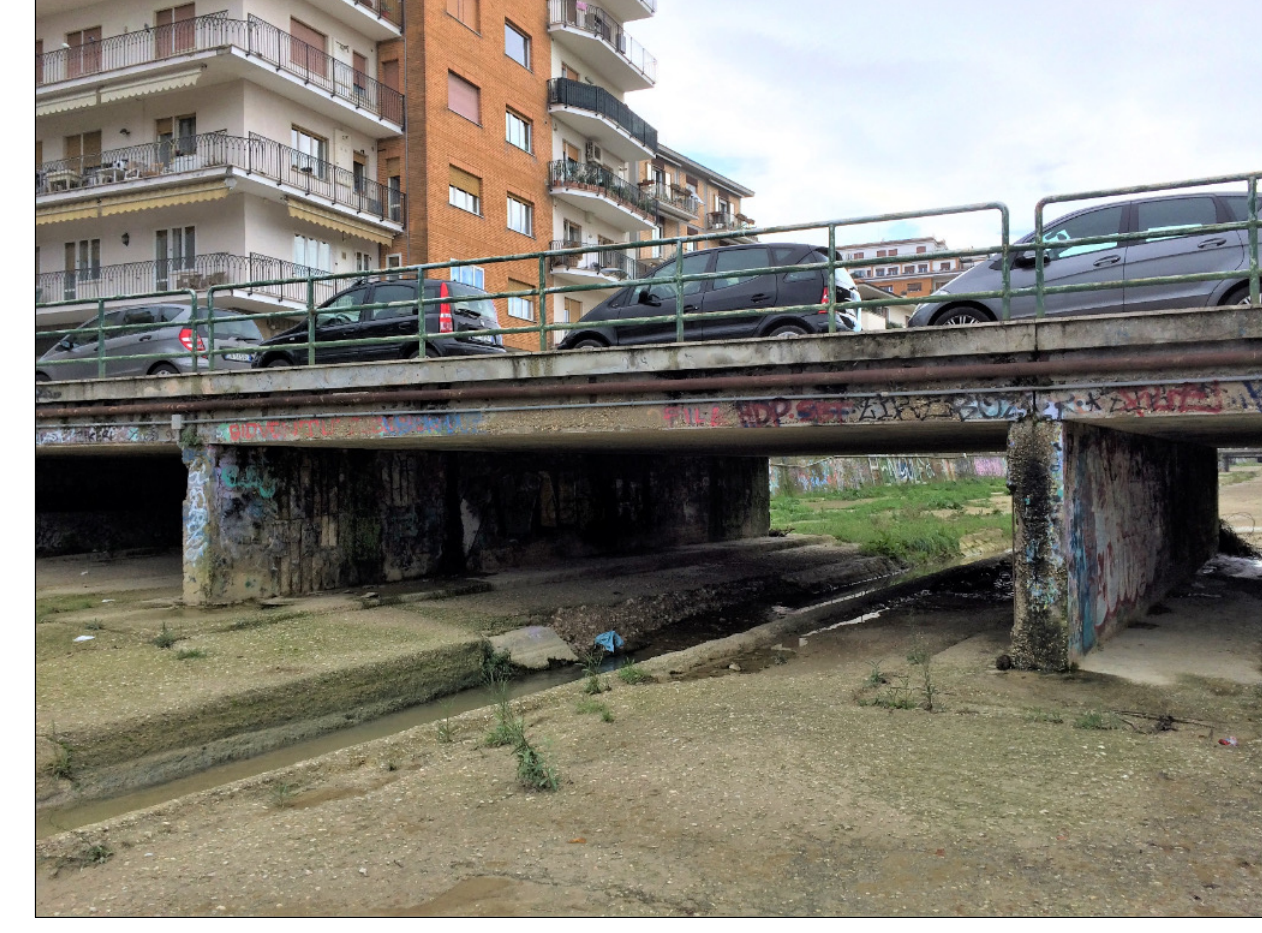
FOTO PONTE di via PIEMONTE lato MONTE
