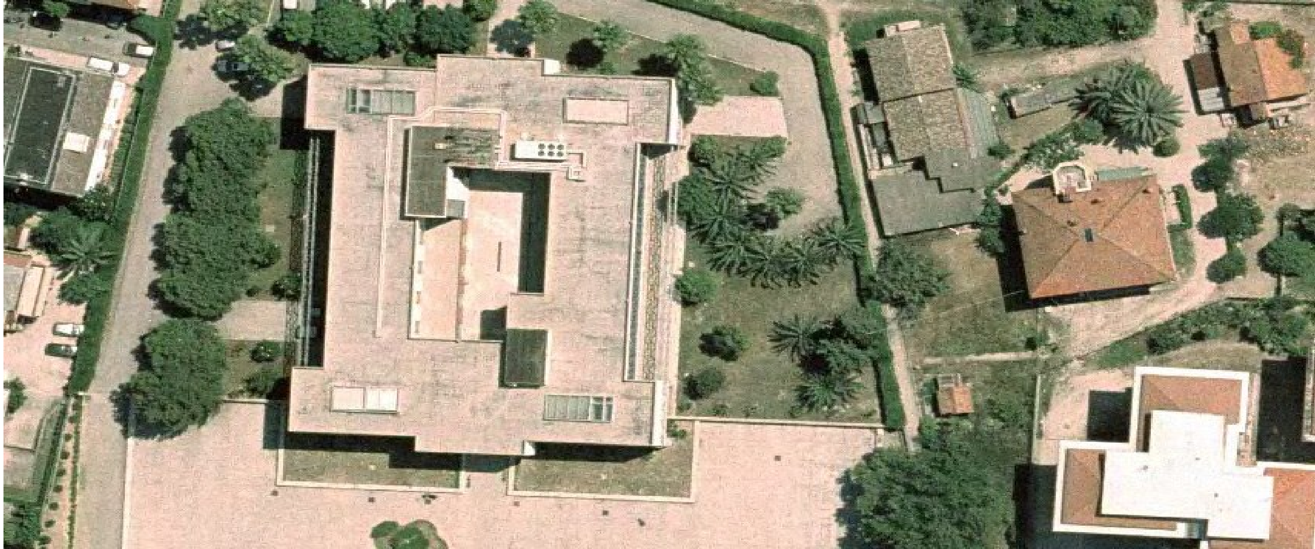
FOTO AEREA DELLE COPERTURE INTERESSATE
