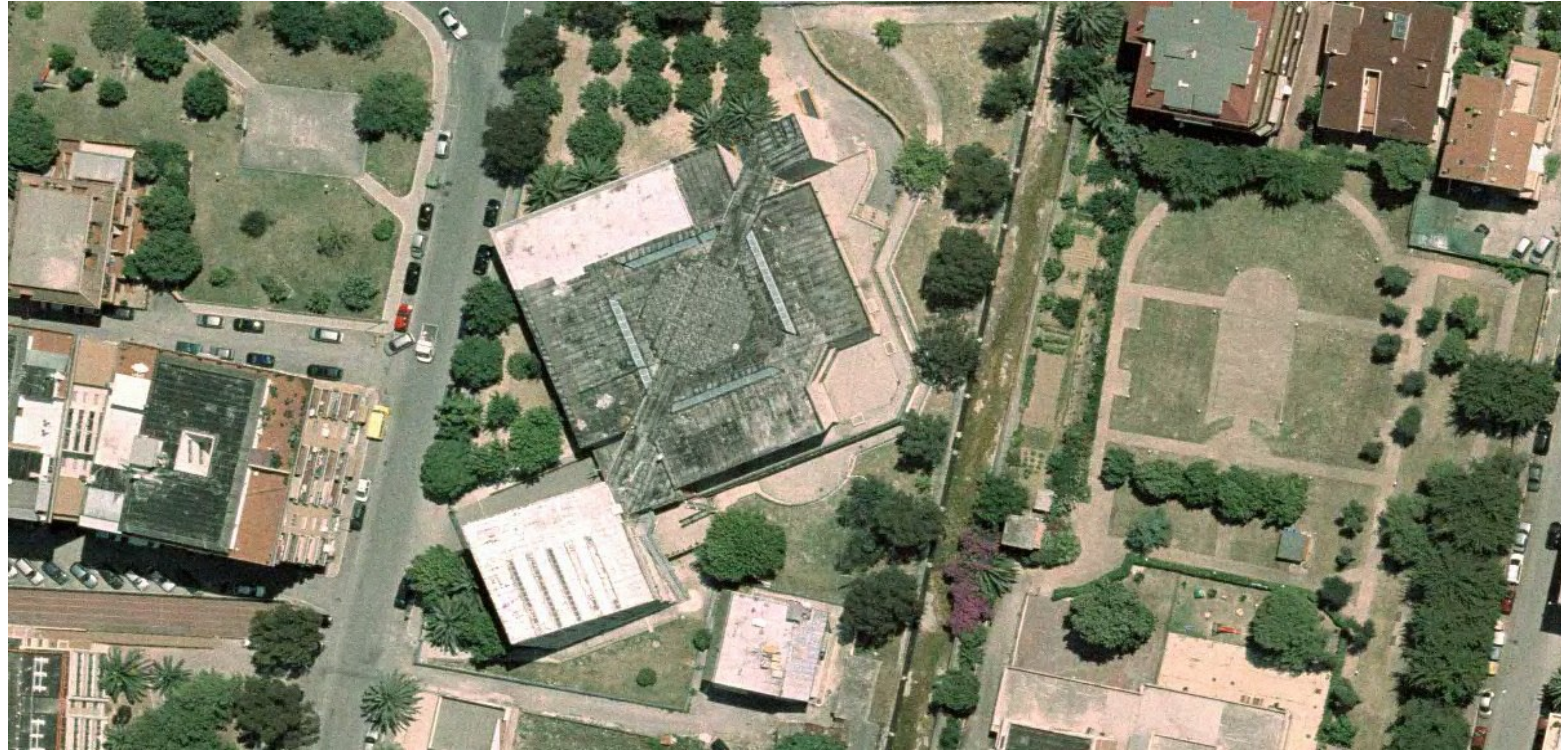
FOTO AEREA DELLE COPERTURE INTERESSATE
