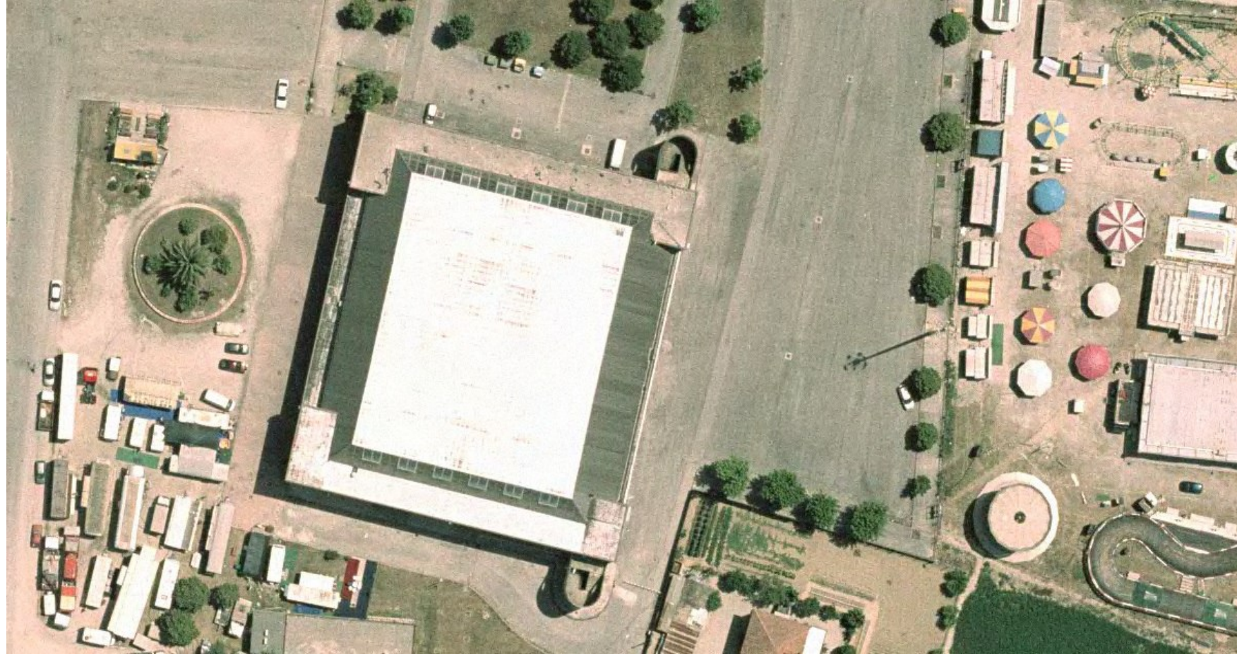
FOTO AEREA DELLE COPERTURE INTERESSATE
