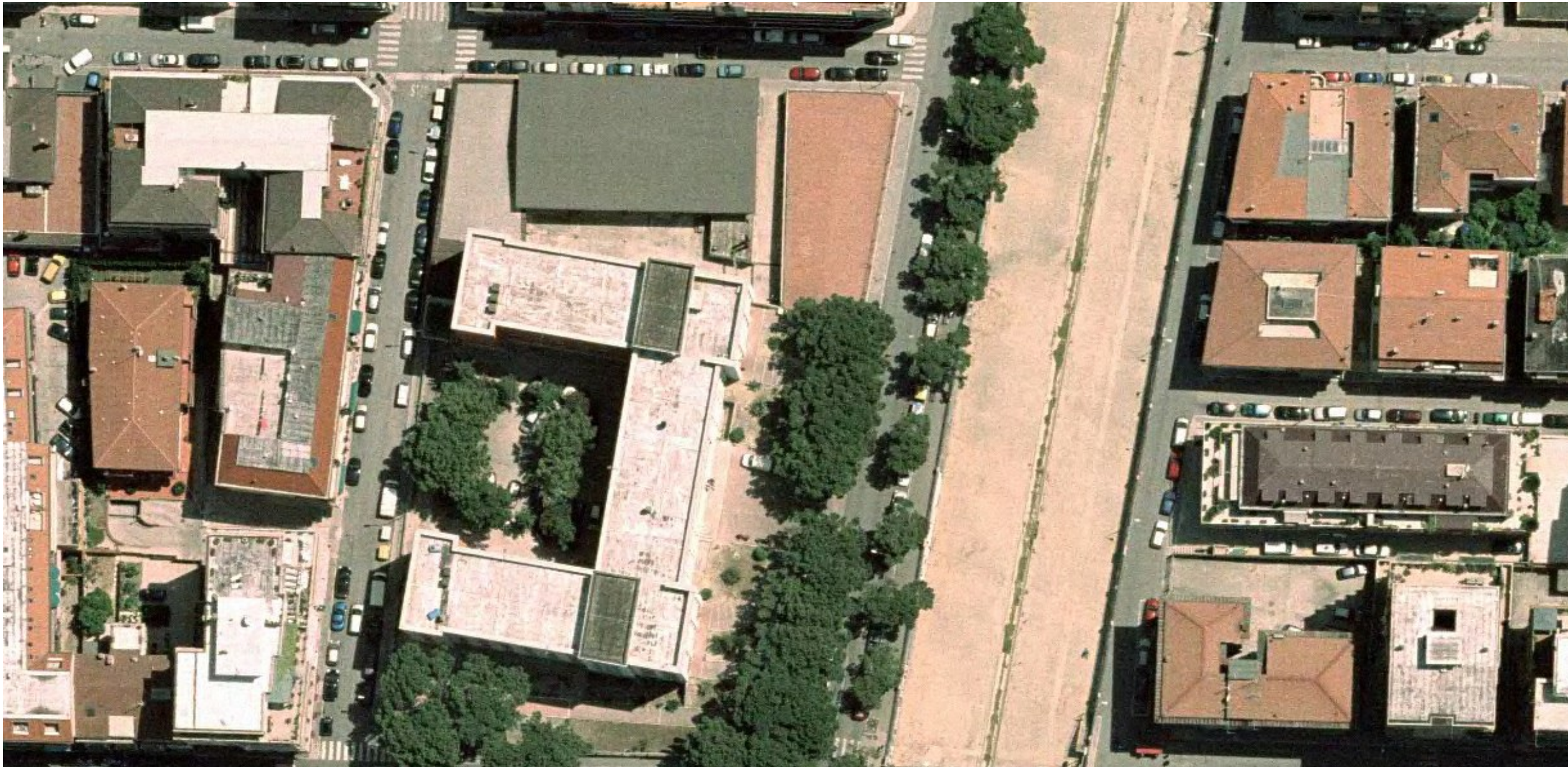
FOTO AEREA DELLE COPERTURE INTERESSATE
