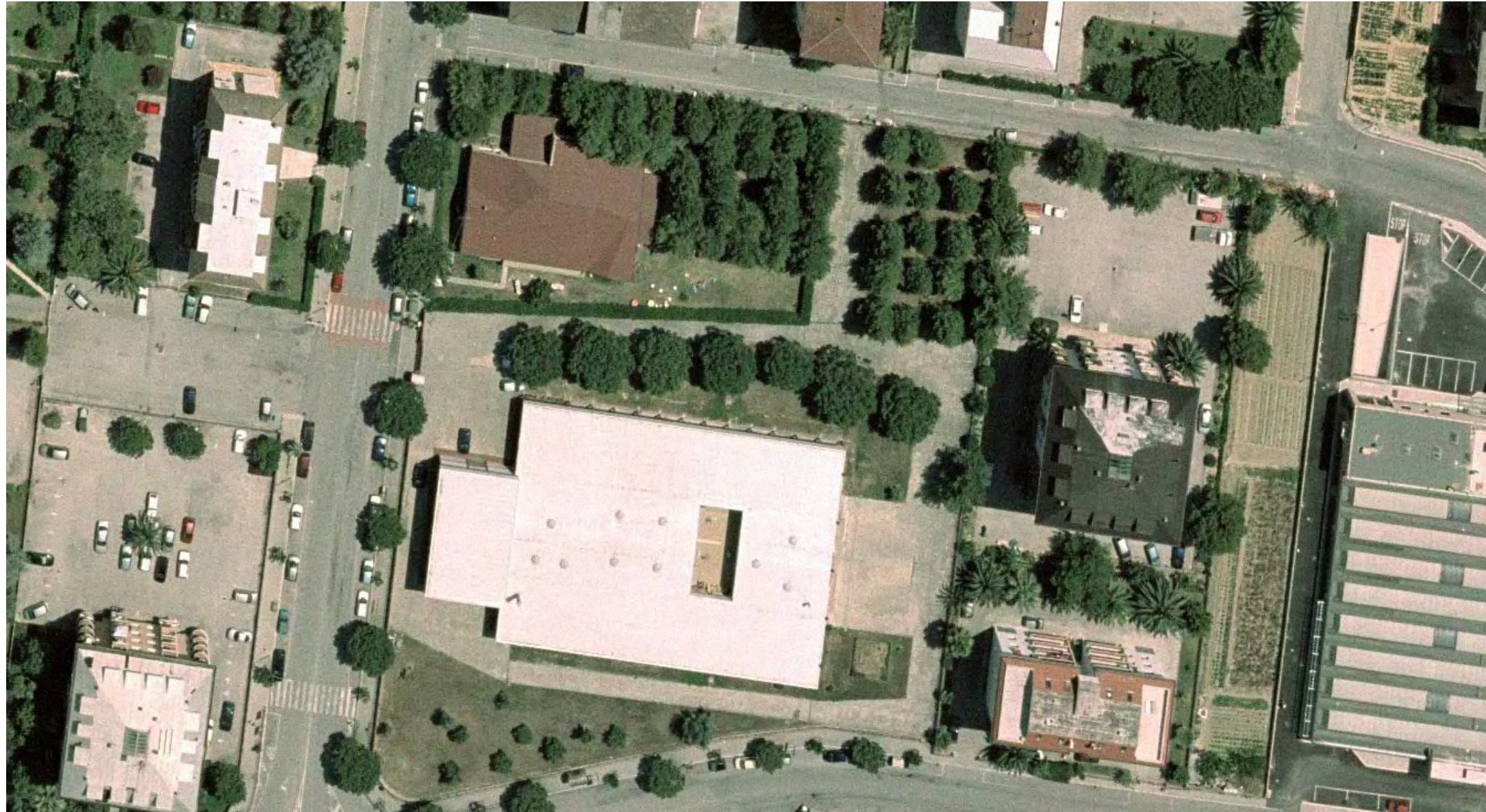
FOTO AEREA DELLE COPERTURE INTERESSATE
