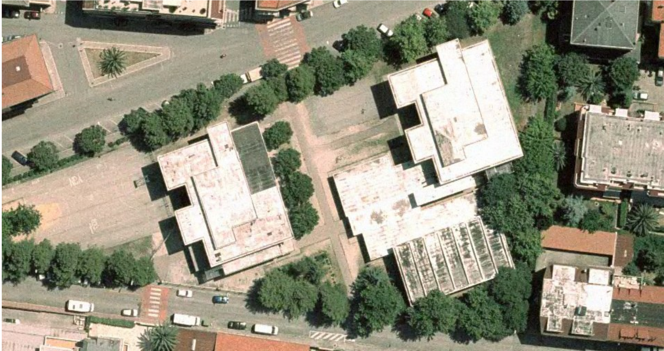
FOTO AEREA DELLE COPERTURE INTERESSATE
