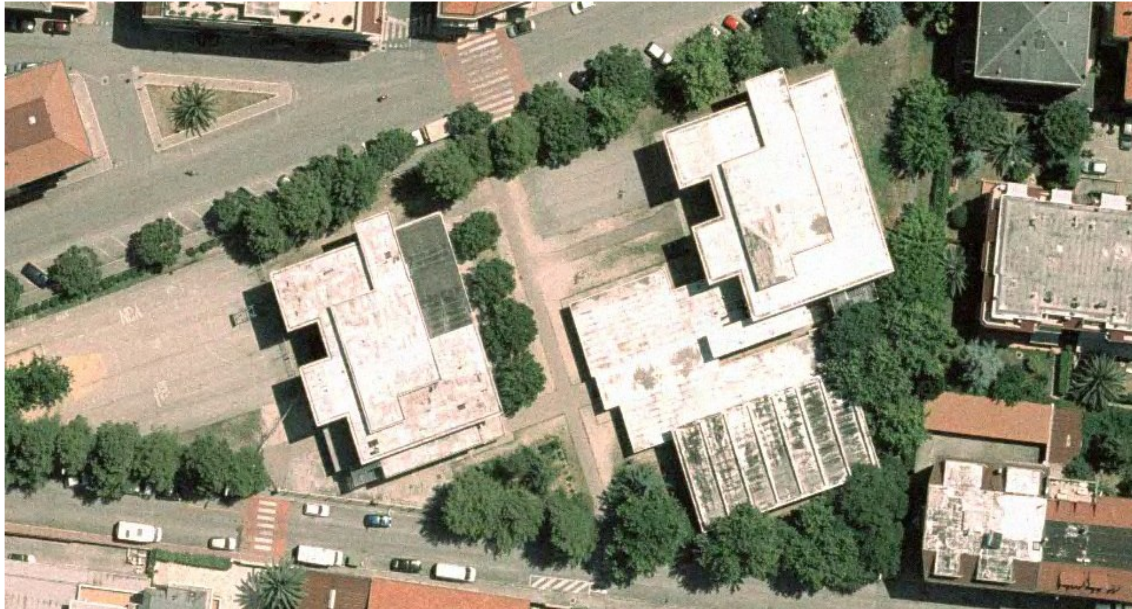
FOTO AEREA DELLE COPERTURE INTERESSATE
