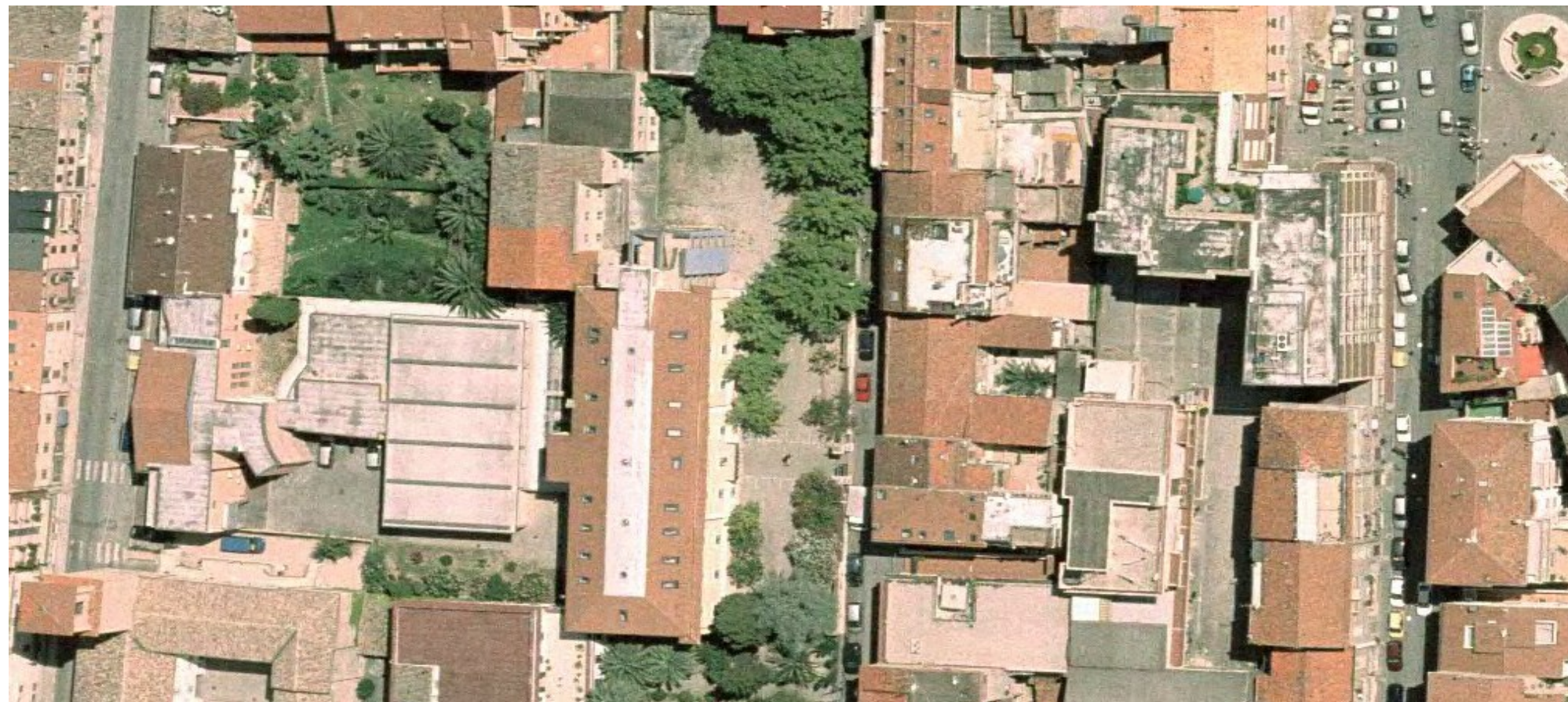
FOTO AEREA DELLE COPERTURE INTERESSATE
