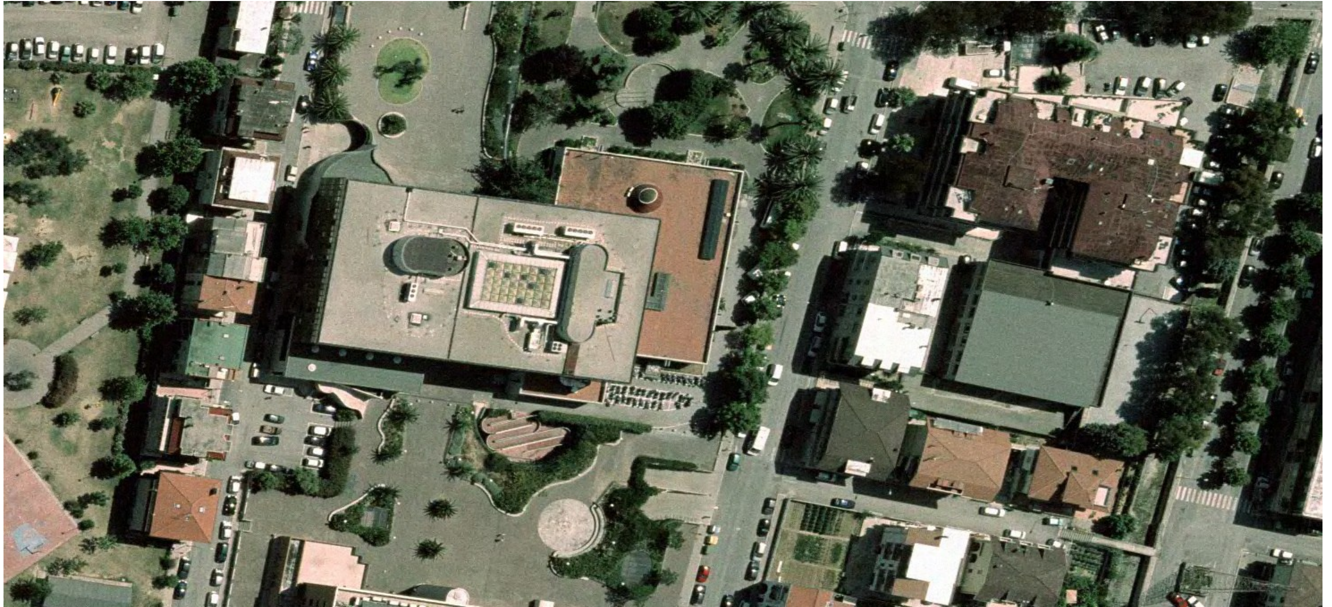
FOTO AEREA DELLE COPERTURE INTERESSATE
