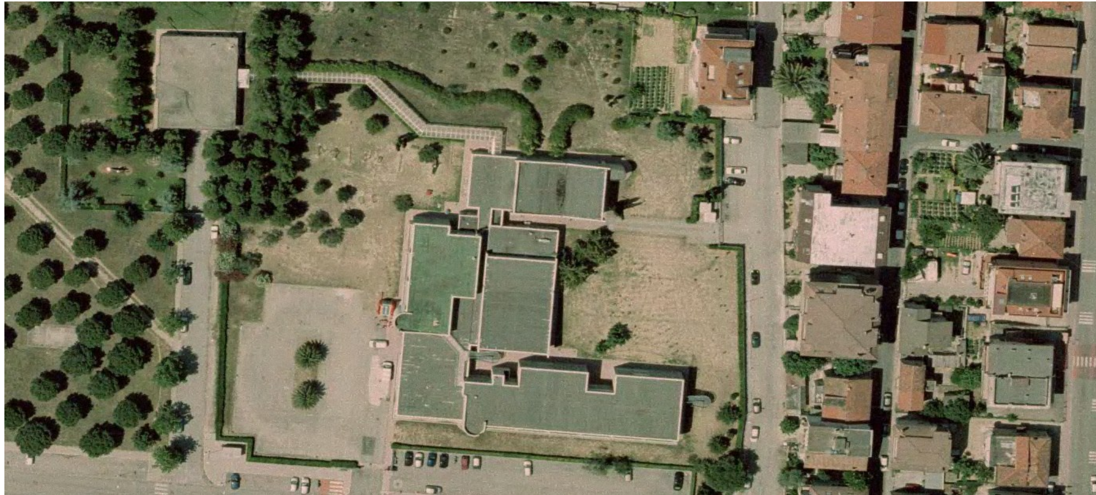
FOTO AEREA DELLE COPERTURE INTERESSATE
