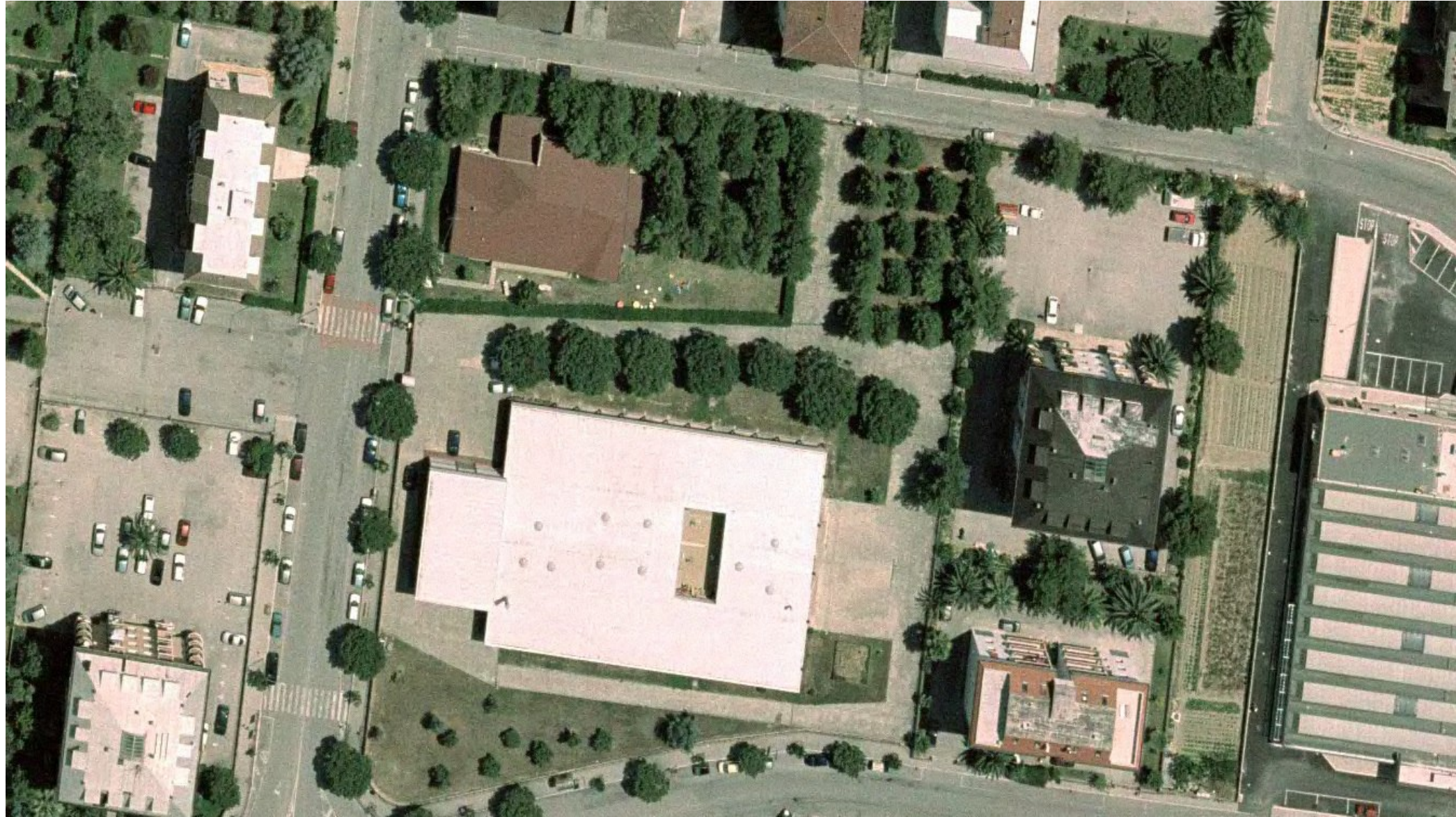
FOTO AEREA DELLE COPERTURE INTERESSATE
