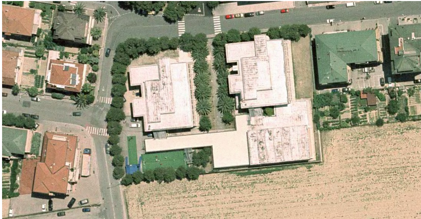
FOTO AEREA DELLE COPERTURE INTERESSATE
